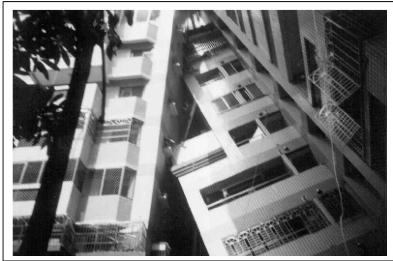
相片 1 F 棟傾倒靠於 B 棟
